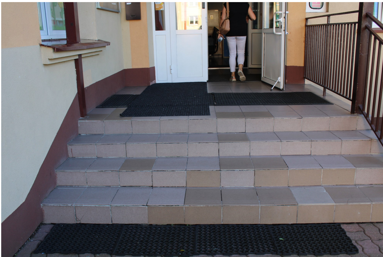
Fot 1. Widok schodów od strony wejścia.
