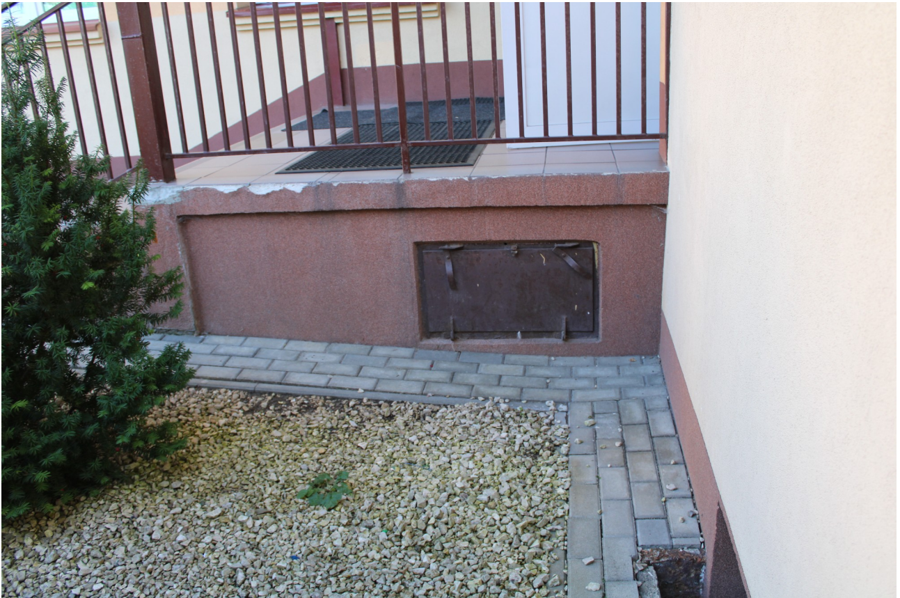
Fot 3. Widok schodów ściana boczna.
