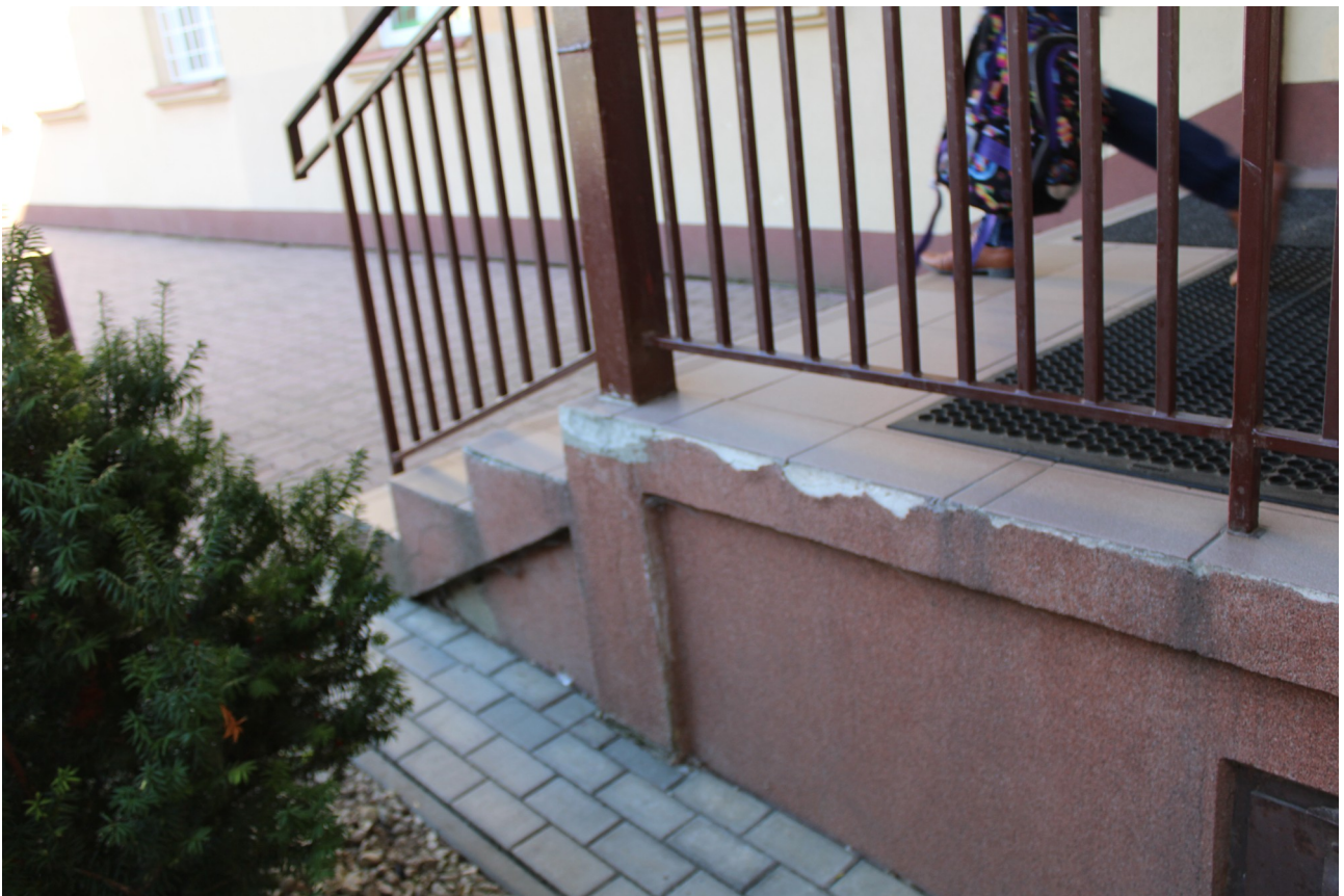
Fot 4. Widok schodów ściana boczna.
