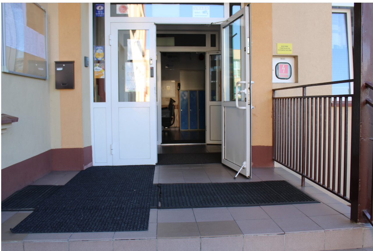
Fot 2. Widok schodów od strony wejścia.
