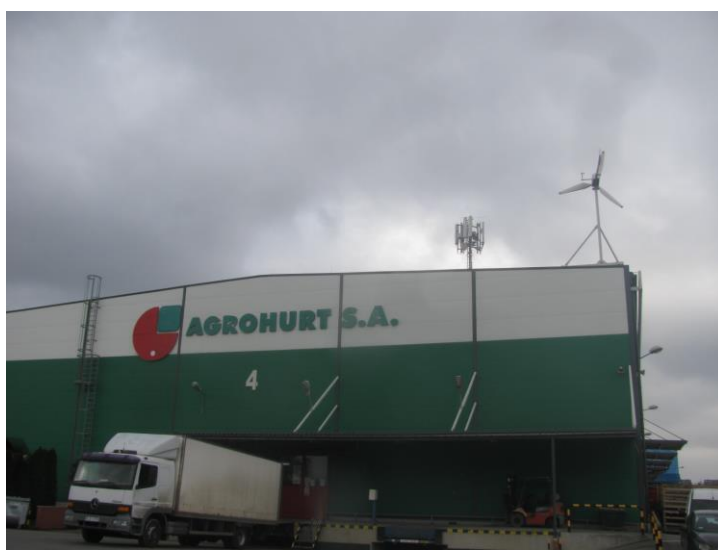
Zał. nr 1: Widok ogólny instalacji radiokomunikacyjnej.
