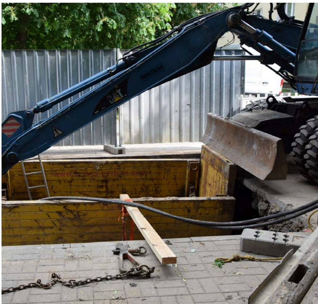
przebudowa kanalizacji deszczowej w rejonie ul. Staszica, fot. MPWiK Rzeszów
