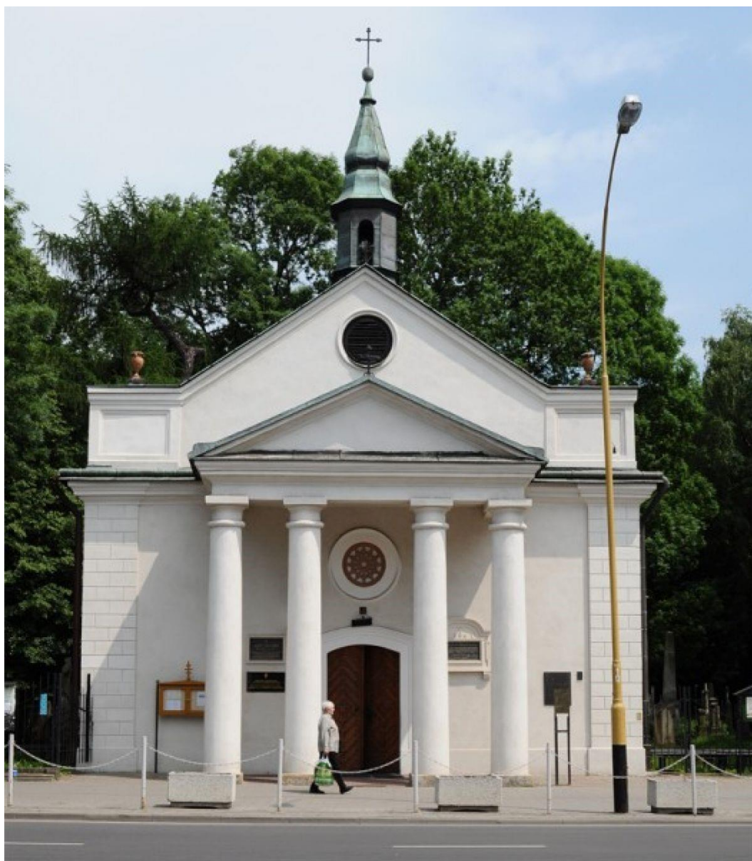
Zdjęcie 7 Cerkiew grekokatolicka, dawny Kościół św. Trójcy, przy której w latach 2021-2022 kontynuowane były prace remontowo-konserwatorskie dotowane z budżetu Gminy Miasto Rzeszów, Podkarpackiego Wojewódzkiego Konserwatora Zabytków i Województwa Podkarpackiego. (Fot. Anna Hardt)
