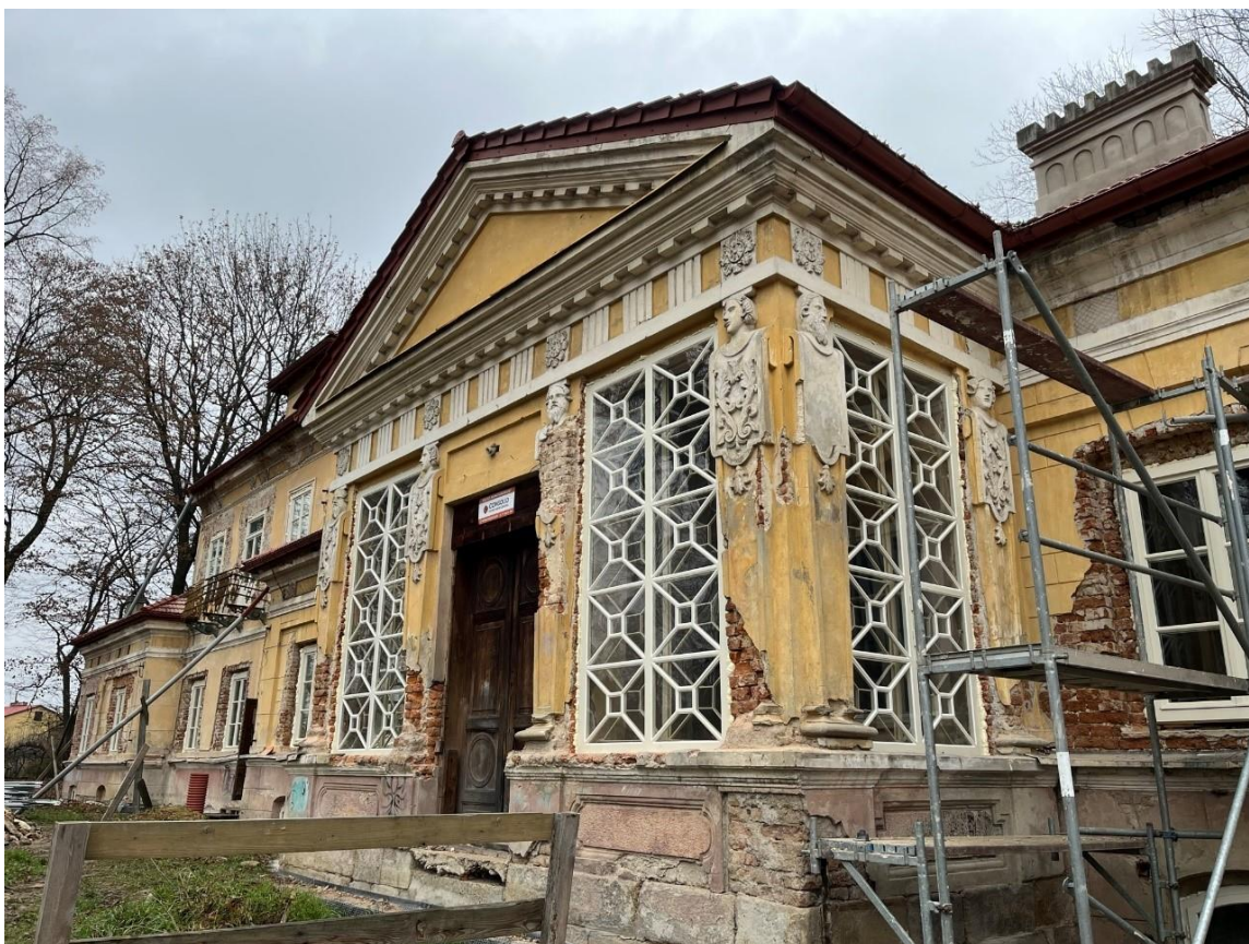
Zdjęcie 8 Dwór Chłapowskich z zespołu dworsko parkowego w Rzeszowie-Słocinie, przy którym w latach 2021-2022 kontynuowane były prace remontowo-konserwatorskie dotowane z budżetu Gminy Miasto Rzeszów i Podkarpackiego Wojewódzkiego Konserwatora Zabytków (Fot. Ludmiła Łapka).
