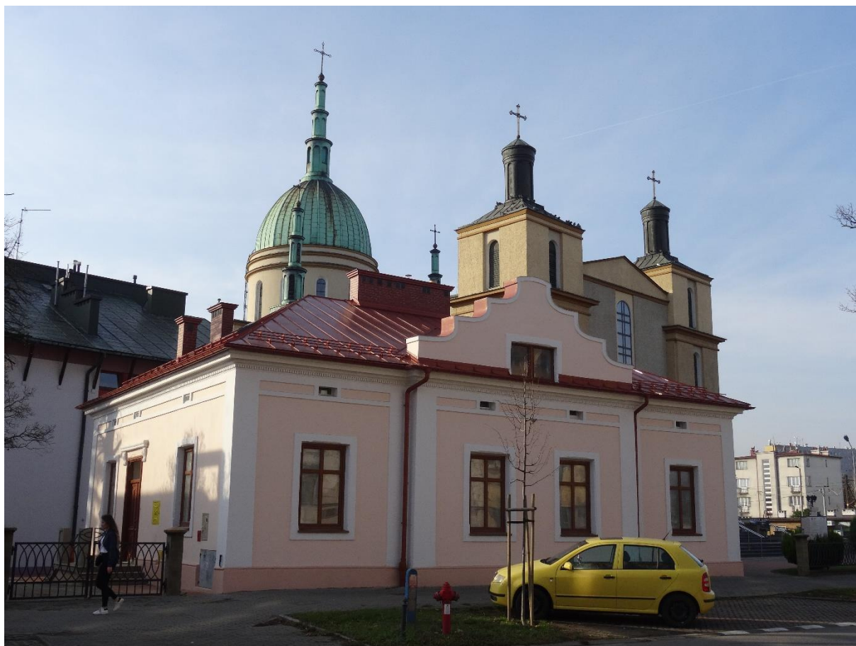
Zdjęcie 6 Dom Parafialny ul. Ks. Jałowego 37 – prace remontowe dotowane w latach 2016-2019 z budżetu Gminy Miasto Rzeszów (fot. Biuro MKZ)
