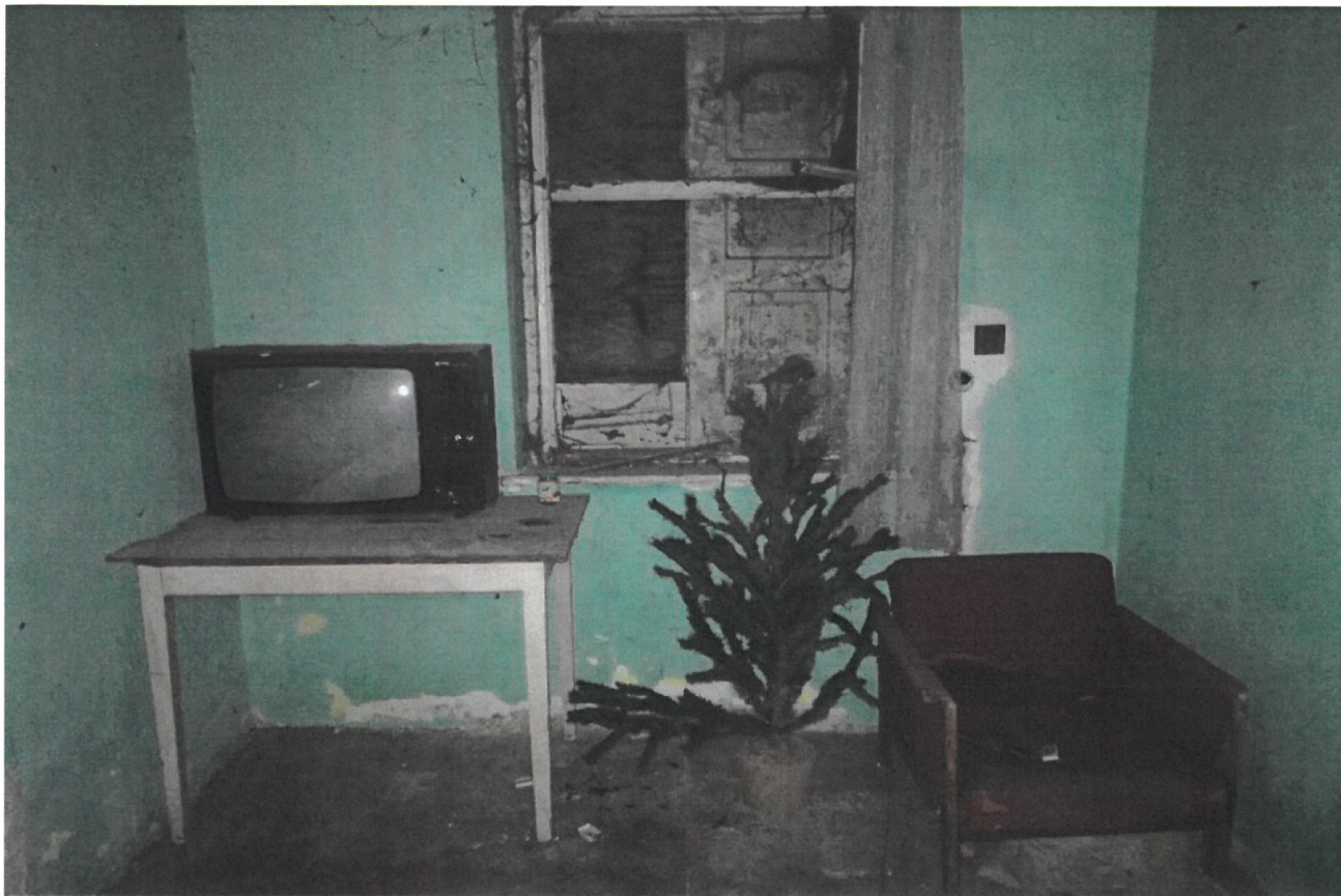
Parter - widoczne okno skrzynkowe oraz pozostawione meble i telewizor
