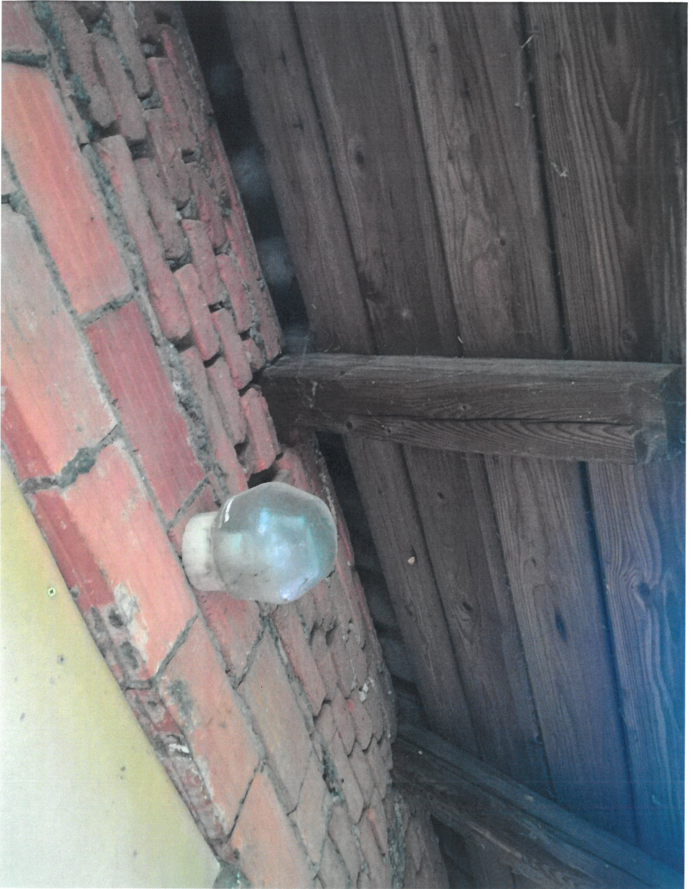
Fragment konstrukcji wieżby dachowej na wejściem do budynku
