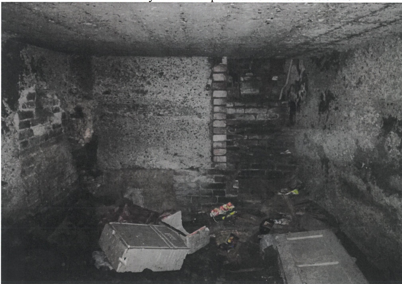
Piwnica - widoczny, betonowy strop i ściany, murowane schody oraz śmieci
