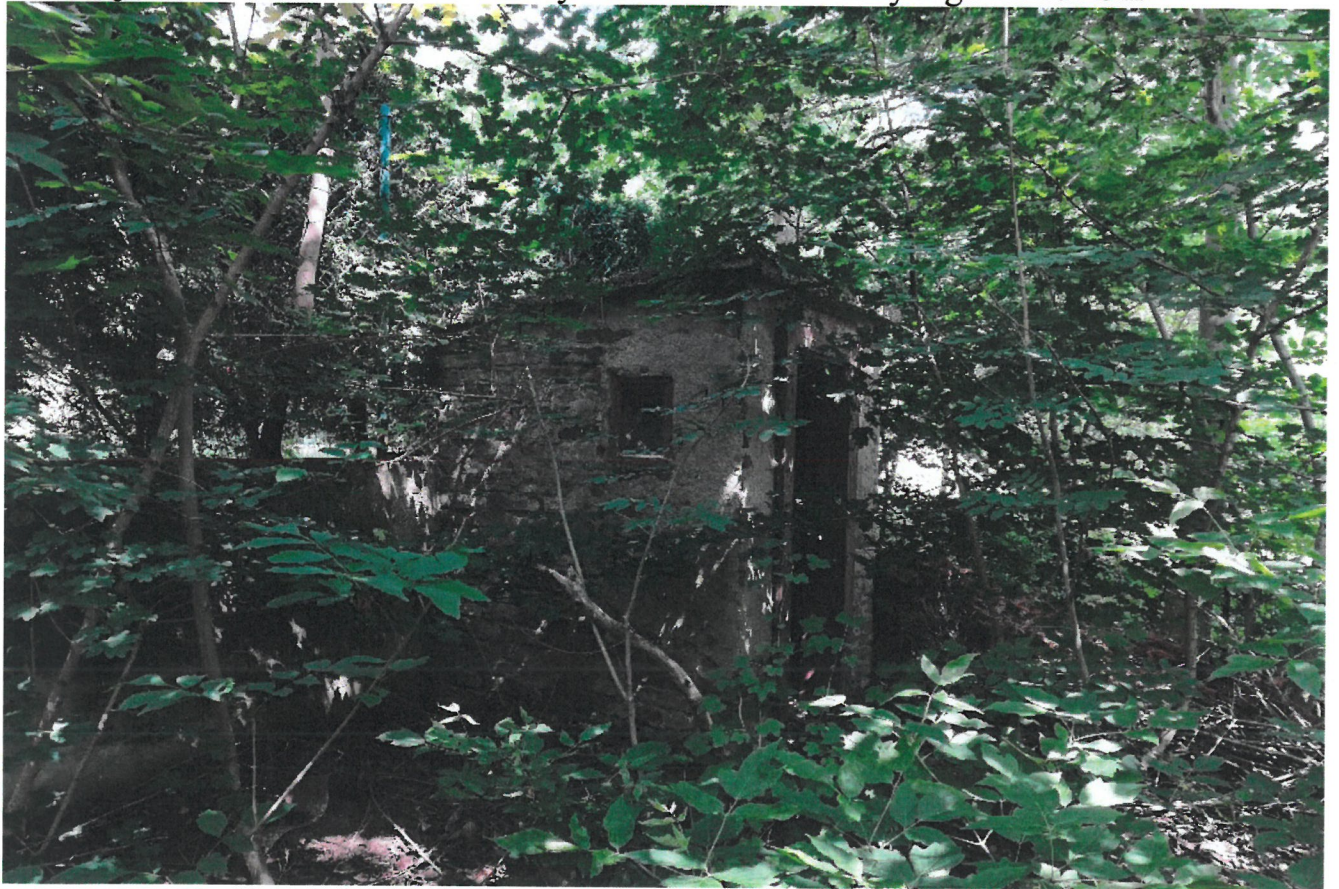
WC typu „Sławojka”, na drugim planie ogrodzenie z siatki stalowej na słupkach
