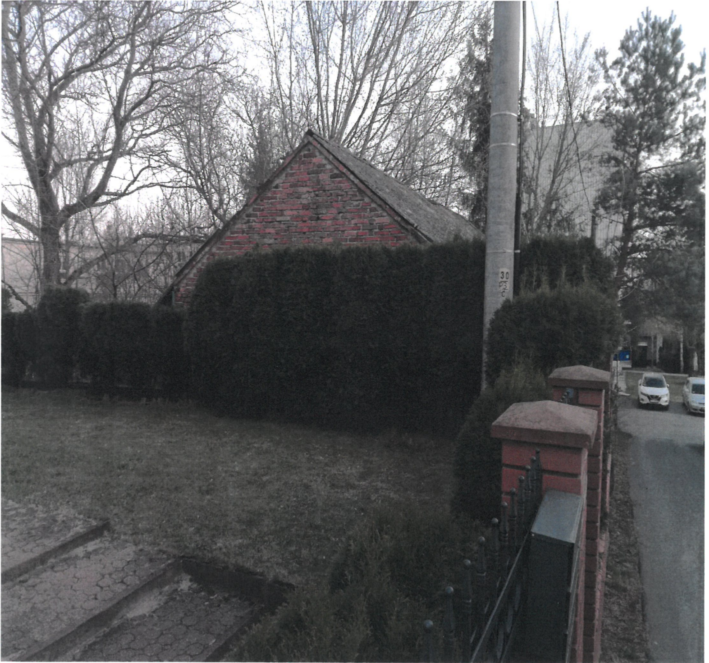
Północna elewacja budynku. Widoczne połączenie z ogrodzeniem na sąsiedniej działce oraz słup sieci energetycznej
