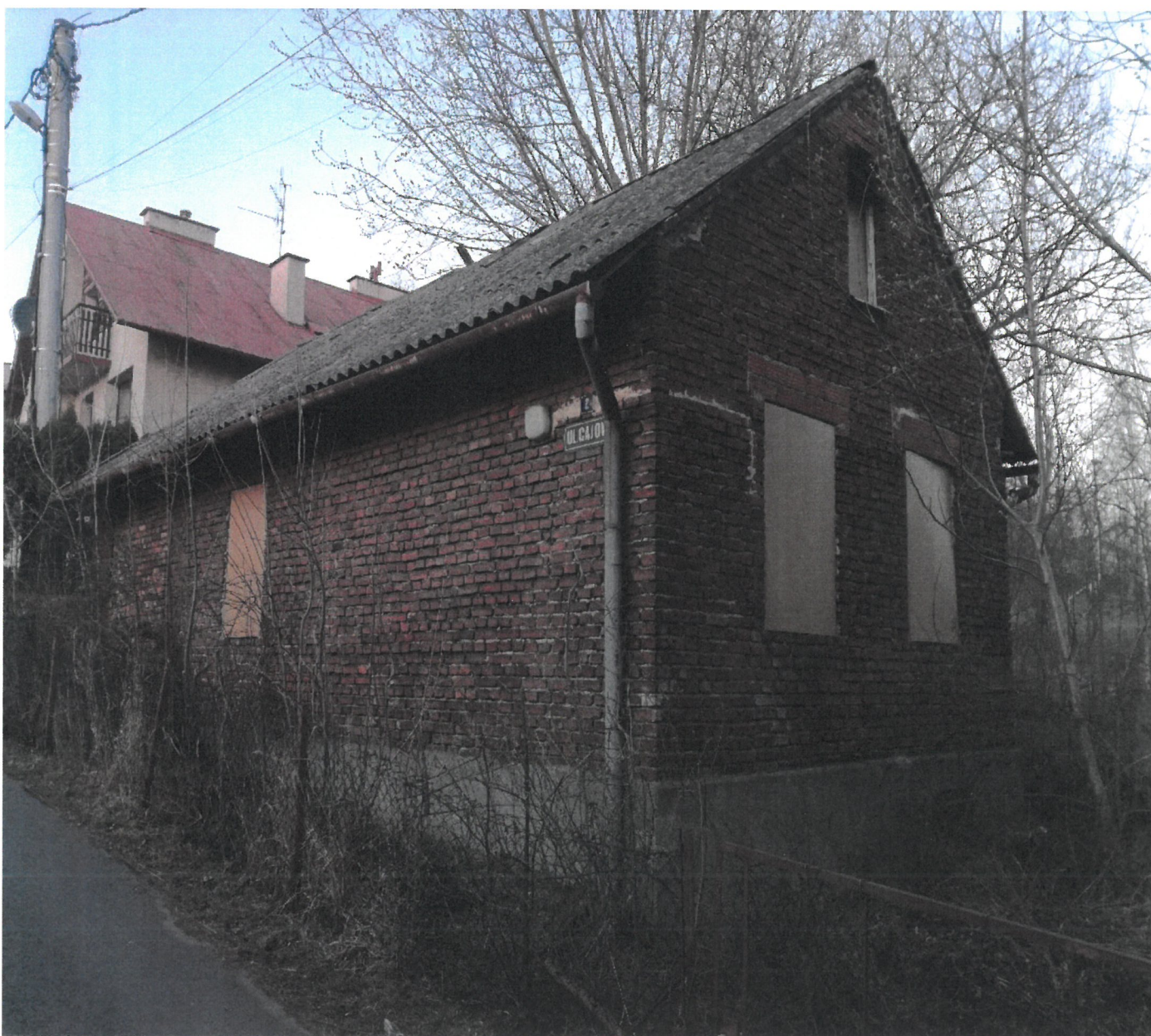
Widok ogólny budynku na elewacje południową i zachodnią - widoczna linia energetyczna przebiegająca bezpośrednio przy budynku
