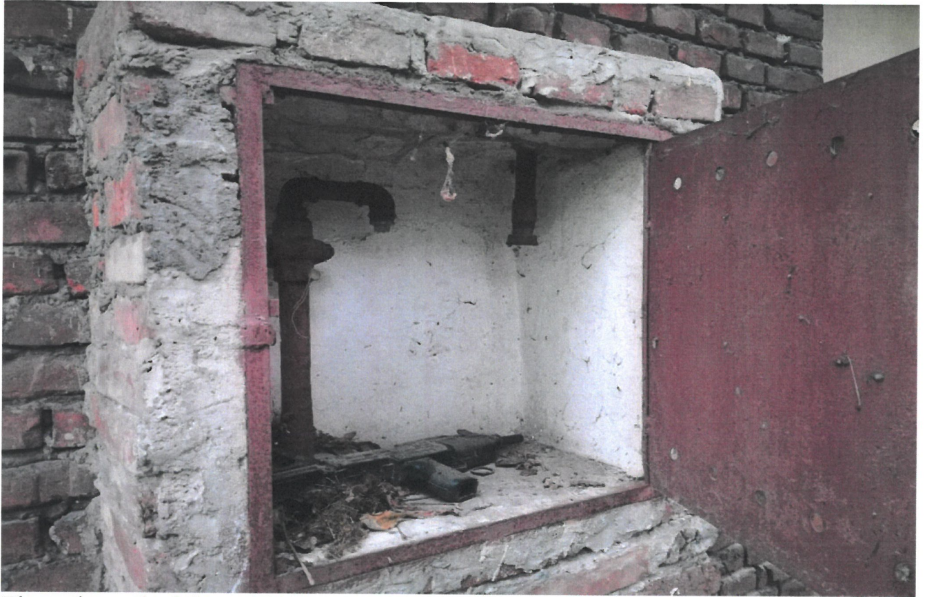
Elewacja wschodnia - widoczna skrzynka ze zdemontowanym gazomierzem
