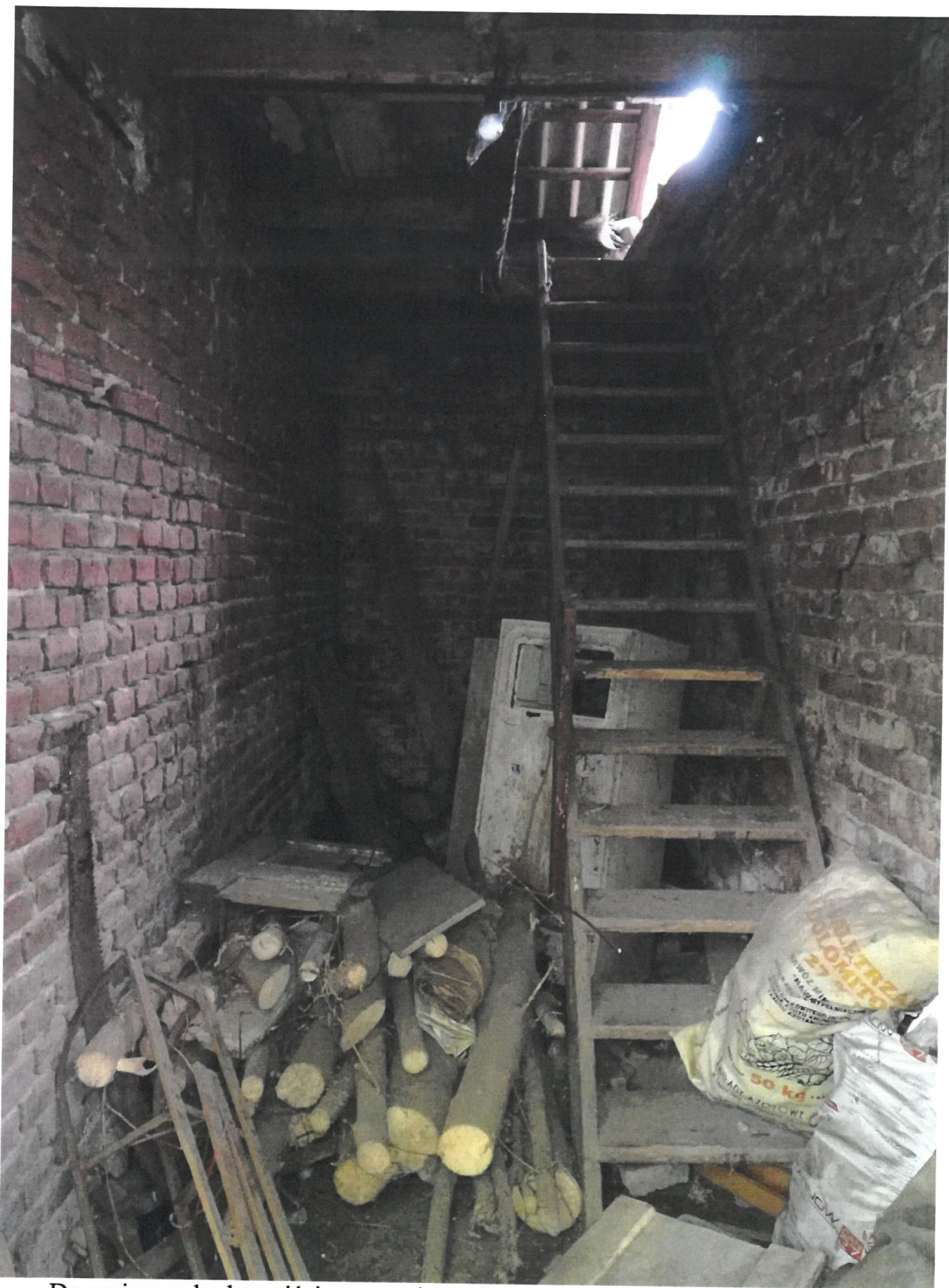
Drewniane schody wejściowe na nieużytkowe poddasze budynku
