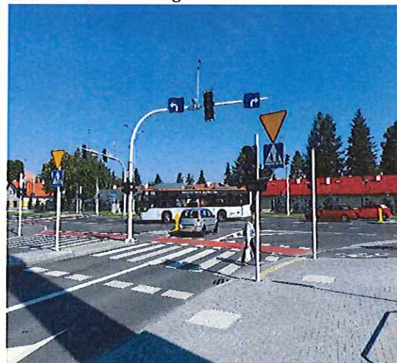
Skrzyżowanie ul. Lwowska – ul. Mieszka I
