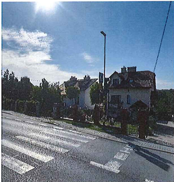
Sygnalizacja świetlna ul. Dębicka
