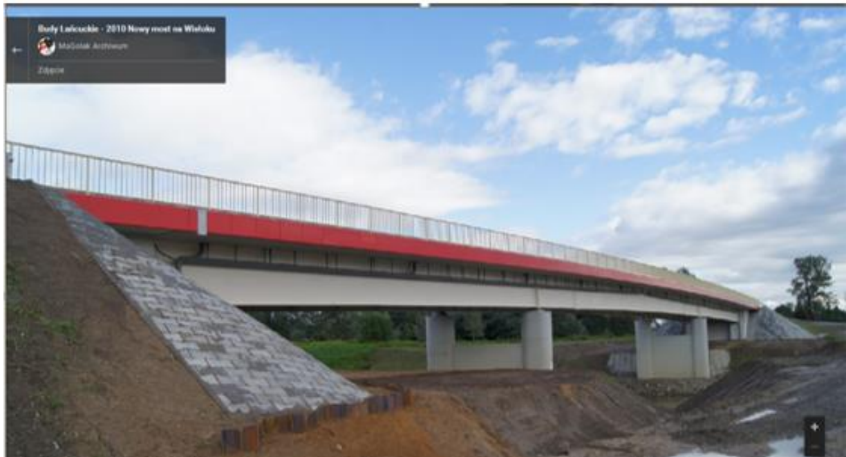
Ryc. 113. Zdjęcie nowowybudowanego mostu na Wiśtoku w Budach Łańcuckich Źródło: Google maps
