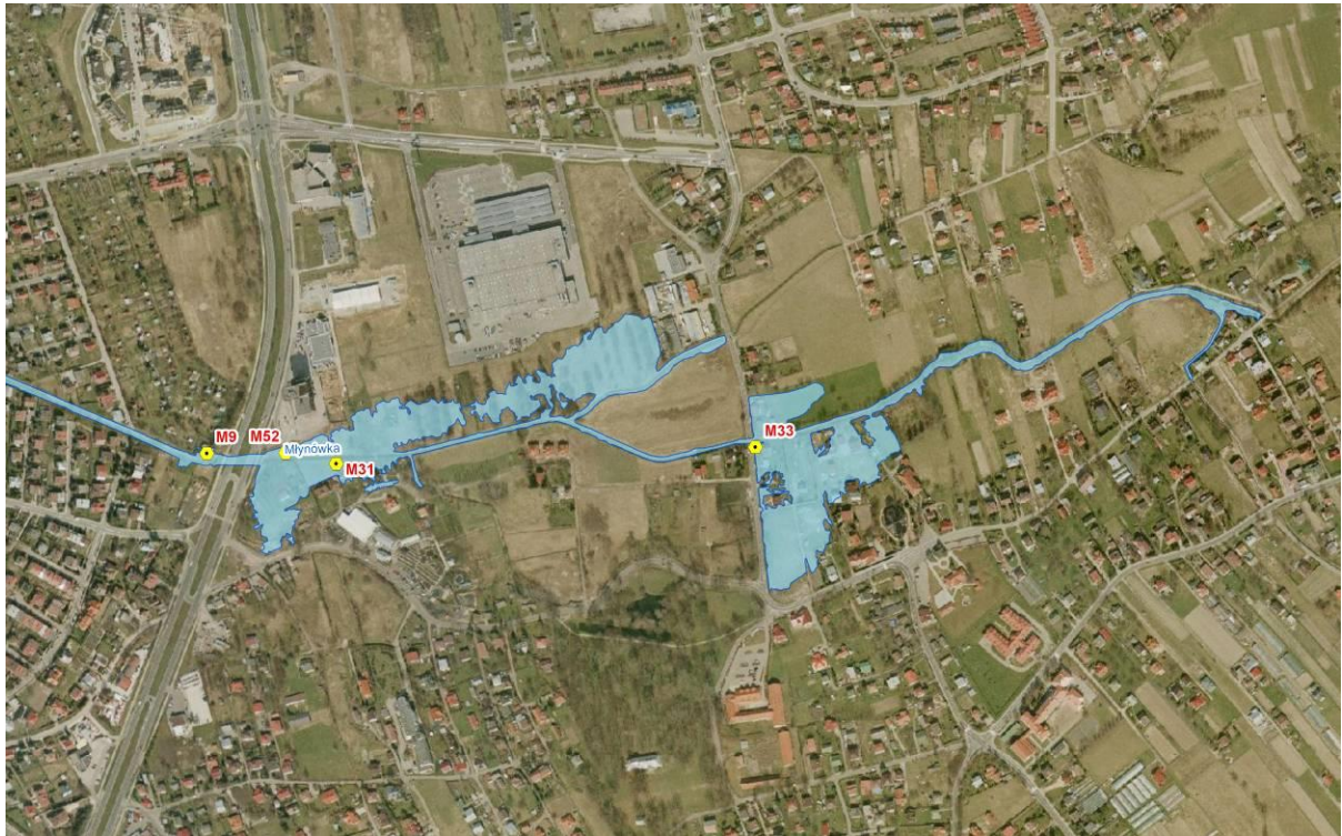
Ryc. 128. Lokalizacja wylotów kanalizacji deszczowej do potoku Młynówka
