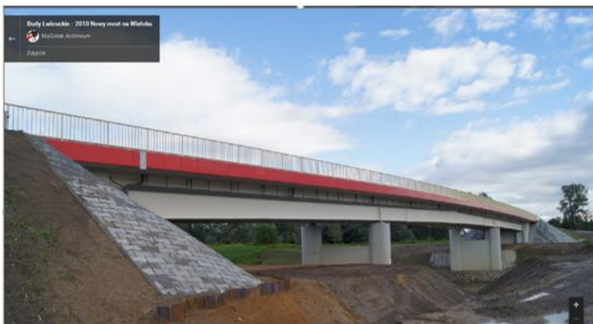
Ryc. 113. Zdjęcie nowowzbudowanego mostu na Wisłoku w Budach Łańcuckich Źródło: Google maps
