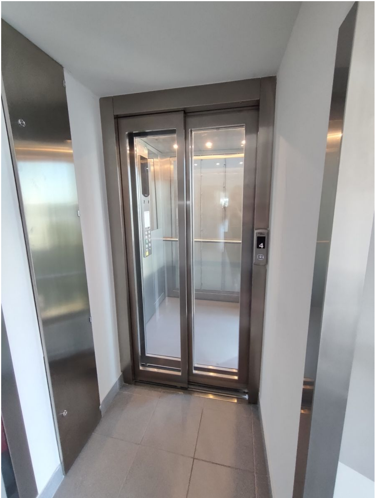
Winda przy budynku Zarządu Transportu Miejskiego w Rzeszowie, fot. archiwum UMRz
