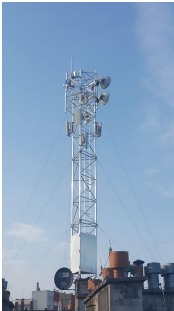
Elementy infrastruktury sieci szkieletowej i dostępowej
