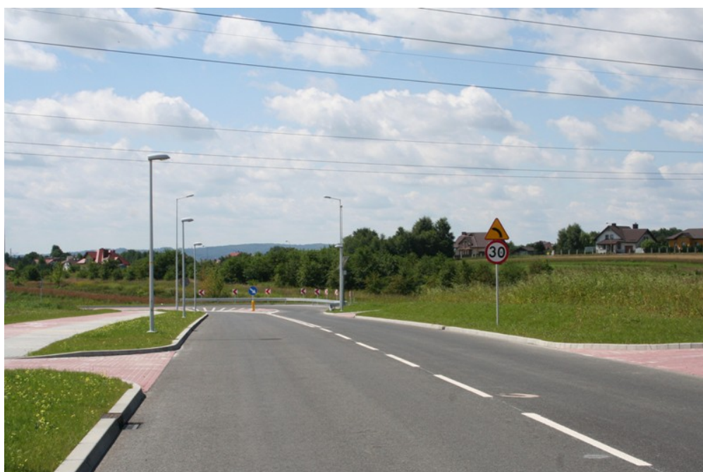
Ulica Przemysłowa po zakończeniu realizacji projektu
