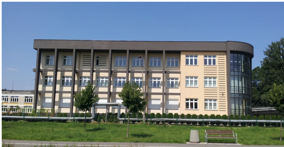
Nowy budynek dydaktyczny Zespołu Szkół Gospodarczych - widok z zewnątrz
