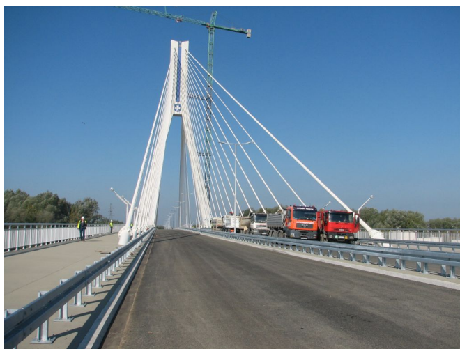
Wrzesień 2015r. - trwają końcowe prace wykończeniowo-porządkowe przy inwestycji dotyczącej przeprawy nad rzeką Wisłok oraz przemysłowymi zbiornikami wodnymi.
