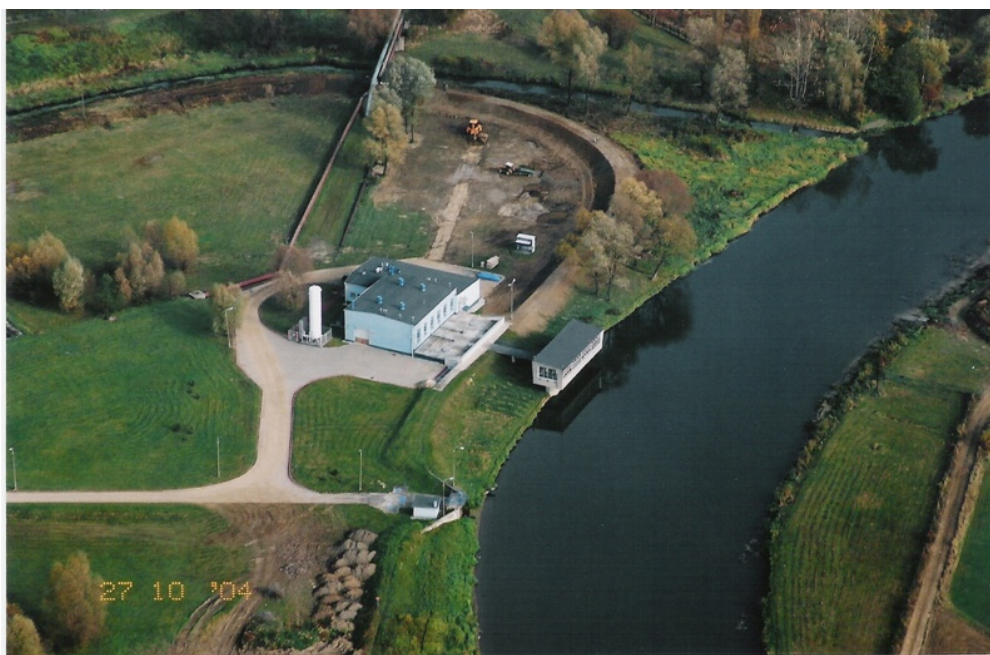
Zakład Uzdatniania Wody Pitnej przed modernizacją - widok z „lotu ptaka”
