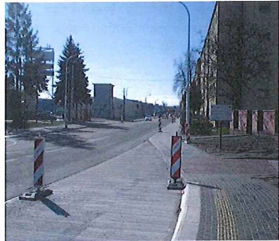
Zadanie 24 - przebudowa ul. Siemińskiego i tablica informacyjna
