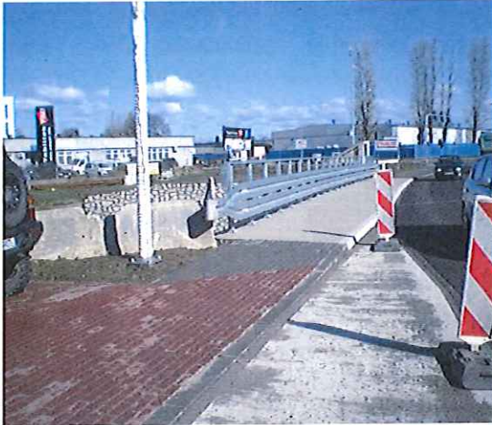
Zadanie 24 - obiekt mostowy potok Przyrwa ul. Siemińskiego
